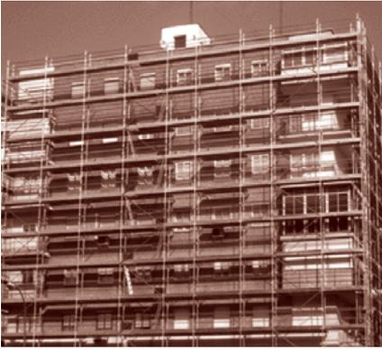
Los andamios de trabajo prefabricados de sistema modular, son estructuras provisionales de una altura de hasta 30 m (aunque en muchos casos es superada), que sirven para la sustentación de las plataformas de trabajo situadas a distintas alturas; este tipo de andamios cumplen según los casos funciones de servicio, carga y protección.
