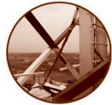
Los conectores, mosquetones, ganchos o pinzas de seguridad, se utilizan para enganchar entre si los diferentes componentes del sistema anticaídas y para su conexión con el sistema de anclaje situado en la estructura de soporte.
