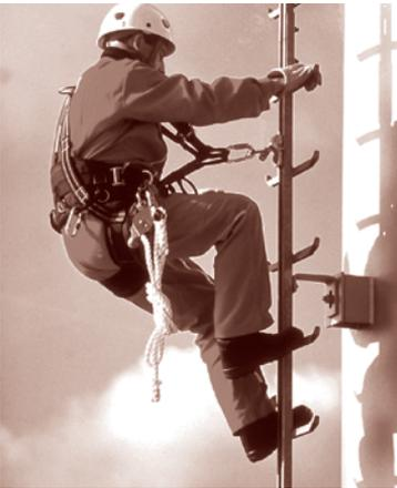
El dispositivo anticaídas deslizante, es un sistema de seguridad de uso obligatorio en todas las escalas fijas. Está compuesto por:
