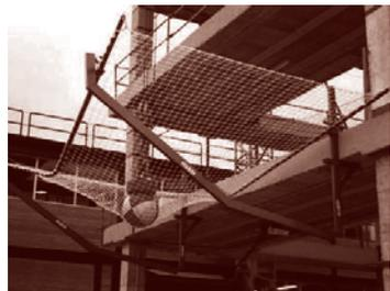
Debe montarse lo más cerca posible del nivel de la superficie de trabajo. Este sistema no es aplicable para proteger el primer forjado debido a que para la fijación del soporte al mismo es necesario que este fraguado.
