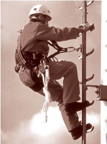
El dispositivo anticaídas es un bloqueador, que puede desplazarse a lo largo de la línea de vida, sin requerir la intervención manual sobre el mismo, cuando se desplaza horizontalmente. Este dispositivo, se bloquea automáticamente, sobre la línea de vida, cuando se produce la caída o un tirón brusco.
